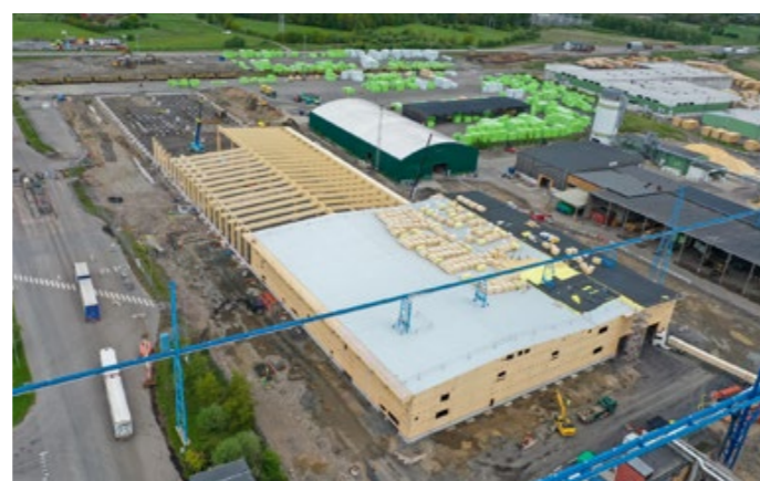
Bygget är nu i full gång. I slutet av maj hade stommen kommit halvvägs och installatörerna hade påbörjat sitt arbete.
