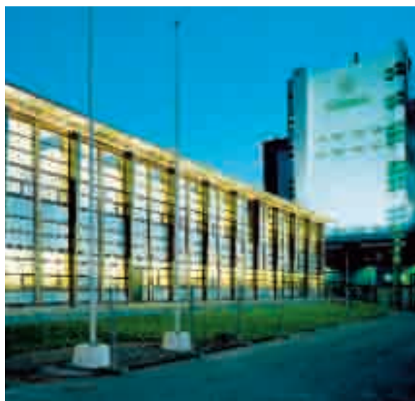
Det nya forskningscentret i Värö har utformats för att vara en kreativ miljö. Mycket trä har använts och de stora glasytorna släpper inte mycket ljus.
