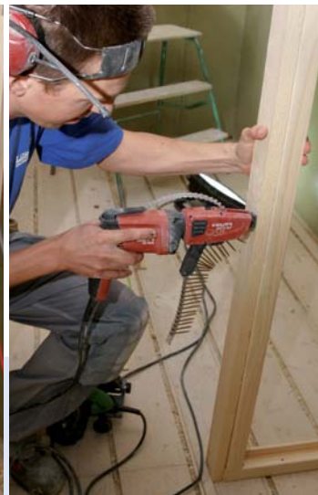
SCHRITT 3 Befestigung des Holzes an SödraSmart Ständer mit Nägeln oder Schrauben. Der Ständer ist fertig zur Montage einer Türzarge.
