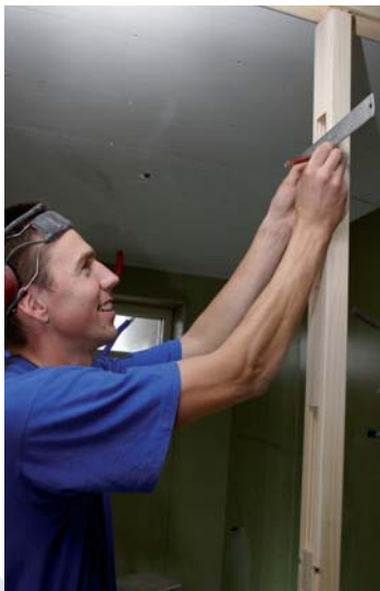
SCHRITT 1 Massnahmen der Türhöhe an dem Ständer.
