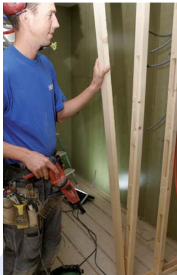
SCHRITT 2 Einpassen eines Sperrholzstreifens oder massiven Ständers.
